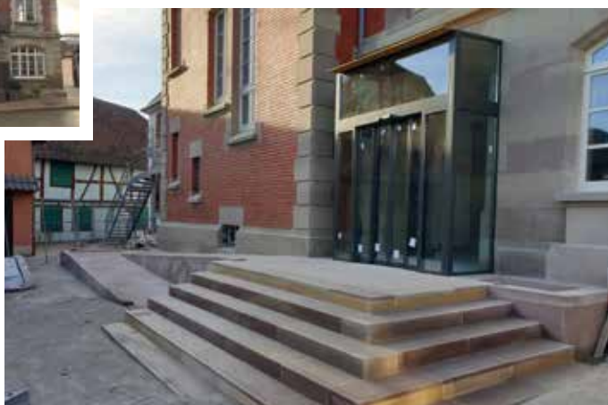
Le déplacement de l'entrée a permis l'aménagement d'une rampe pour personnes à mobilité réduite.
